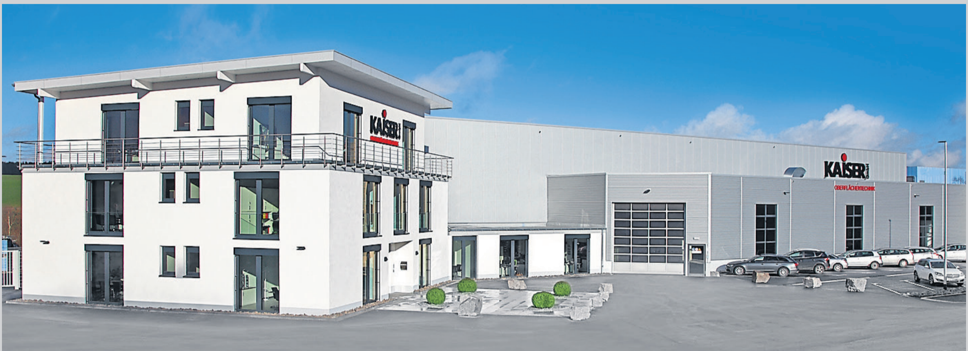
Das neue Verwaltungs- und Logistikgebäude in Erndtebrück-Schameder. (Foto: Kaiser GmbH)
